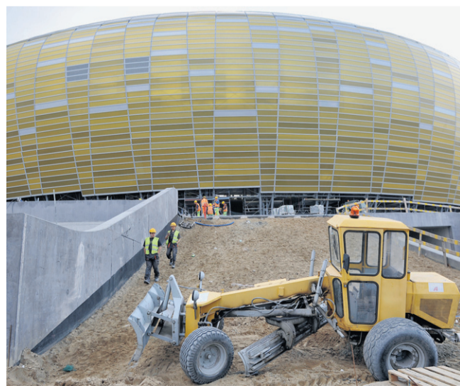
Gdańska PGE Arena to wciąż wielki plac budowy
